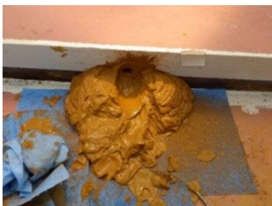
写真-5 内部からの泥の搬出
