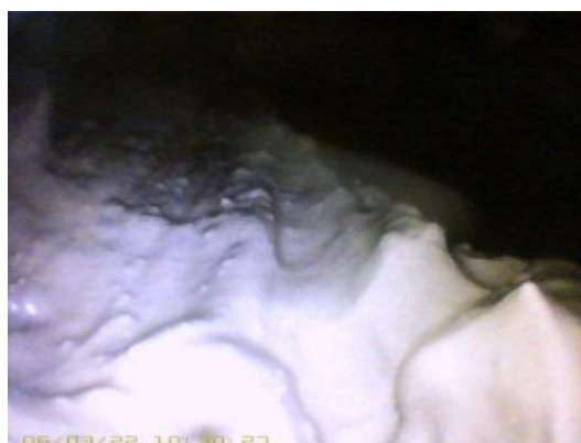
写真-6 内部状況
