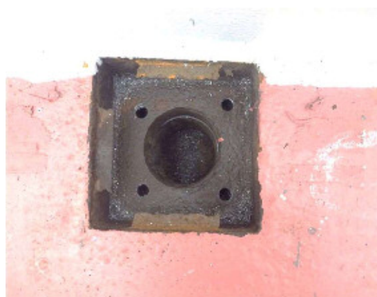
写真-9 排水ます部調査
