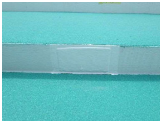
写真－１２ 孔の復旧状況
