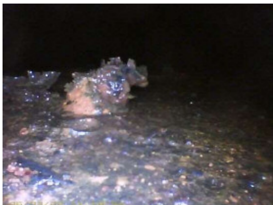
写真-7 ②内部の水の状況
