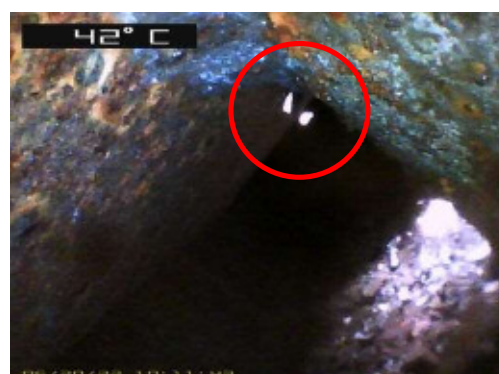
写真-10 排水ます部調査
