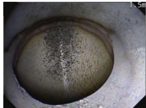
写真－3 排水管調査
