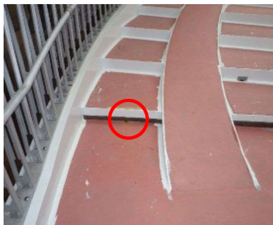
写真－1 泥水発生箇所
