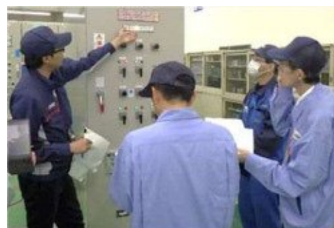
写真 3 メーカーの工場検査
