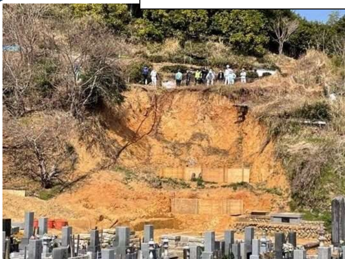
土砂災害箇所（裏山）の現地調査
