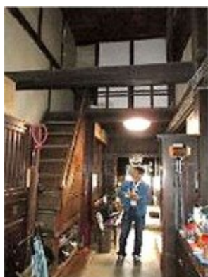
[通り土間耐震診断（建物調査）]
