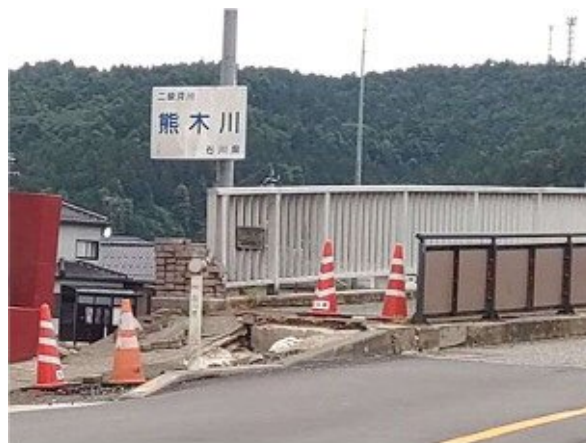
中島大橋（国道 249 号線、七尾市）
