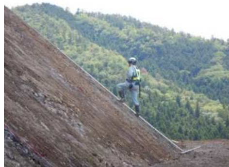
図-1 法面スケッチ作業状況
