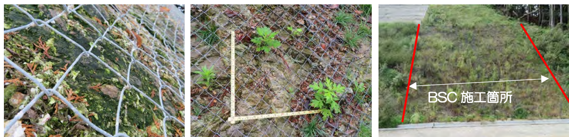
写真4 愛知県の切土法面における適用例 左：BSCの形成(施工0.5カ月後)、中央：植生の侵入(施工6.5カ月後)、右：施工法面(施工10.5カ月後)
