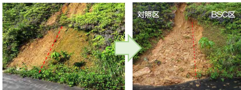
写真 2 沖縄における自然公園内林道への適用例 左：施工 8 カ月後、右：施工 20 カ月後
